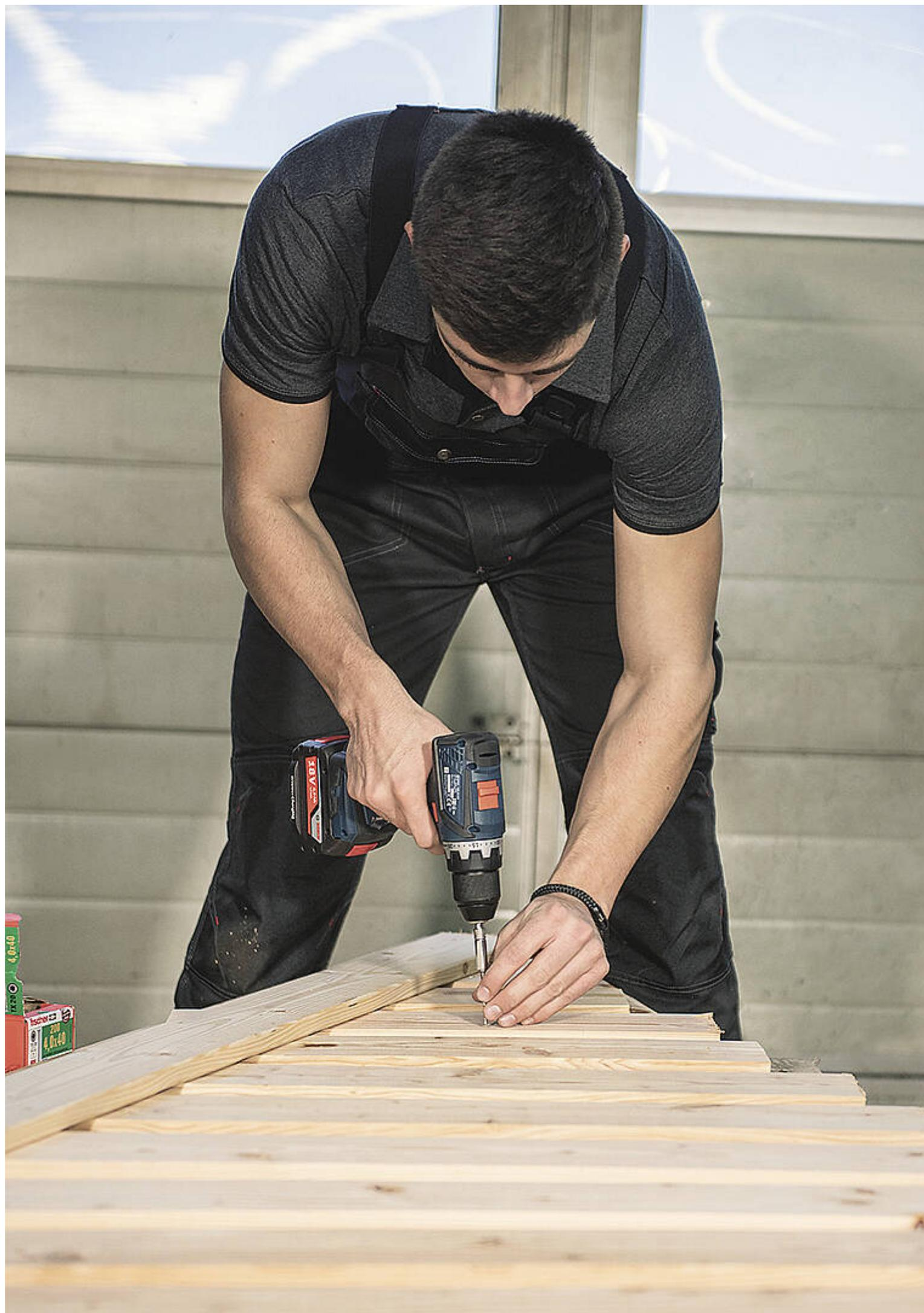
2: Auf dem langen Brett werden die bereits grob zugeschnittenen Holzlatten mithilfe von Schrauben jeweils im gleichen Abstand fixiert. Das Kürzeste ragt leicht über die Spitze hinaus, unter dem Längsten werden circa 30 cm Platz gelassen. Damit die typische Form entsteht, ein langes Brett schräg auf die Latten legen, von der Spitze bis zur breitesten Stelle, und die Schnittlinie einzeichnen.
