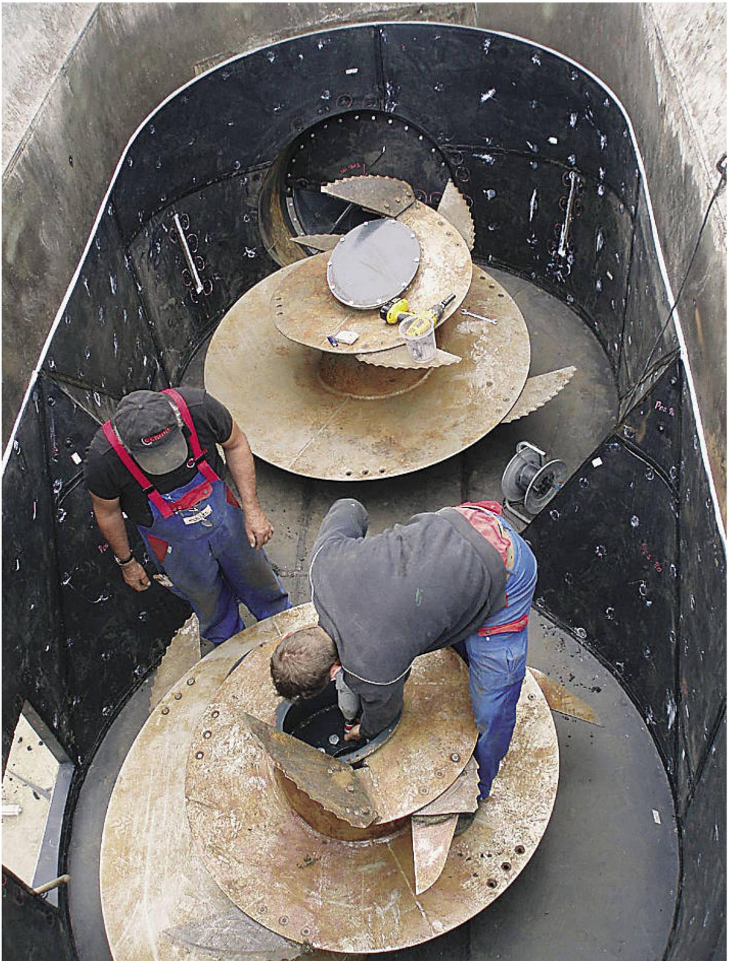
Anbringen von 12 mm starken Robalonplatten an der Behälterinnenwand und den Konusschnecken eines Feststoffmischers.
