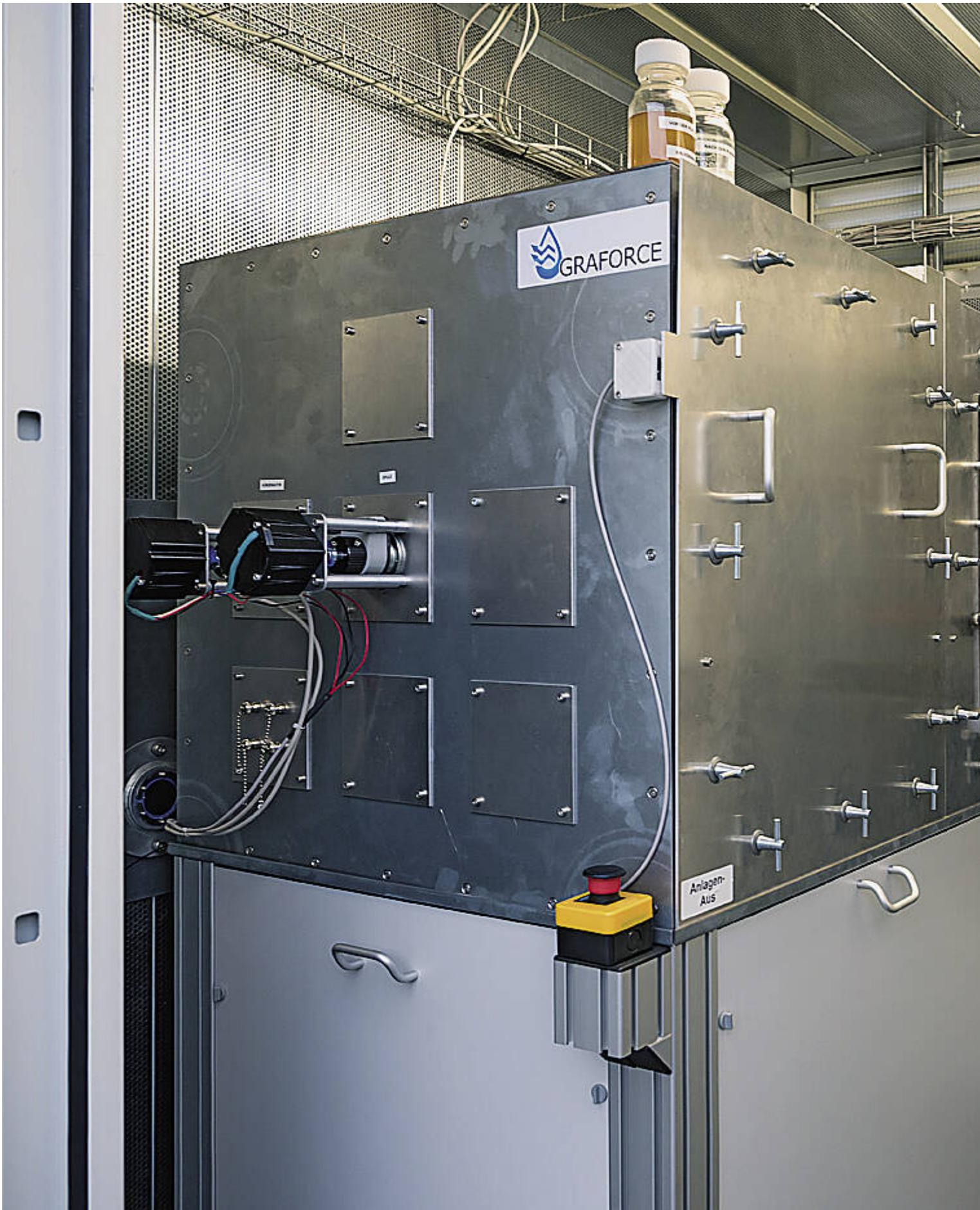
Herzstück der weitgehend automatisch arbeitenden Demonstrationsanlage von Graforce ist der Plasmalyzer, in dem der Wasser
