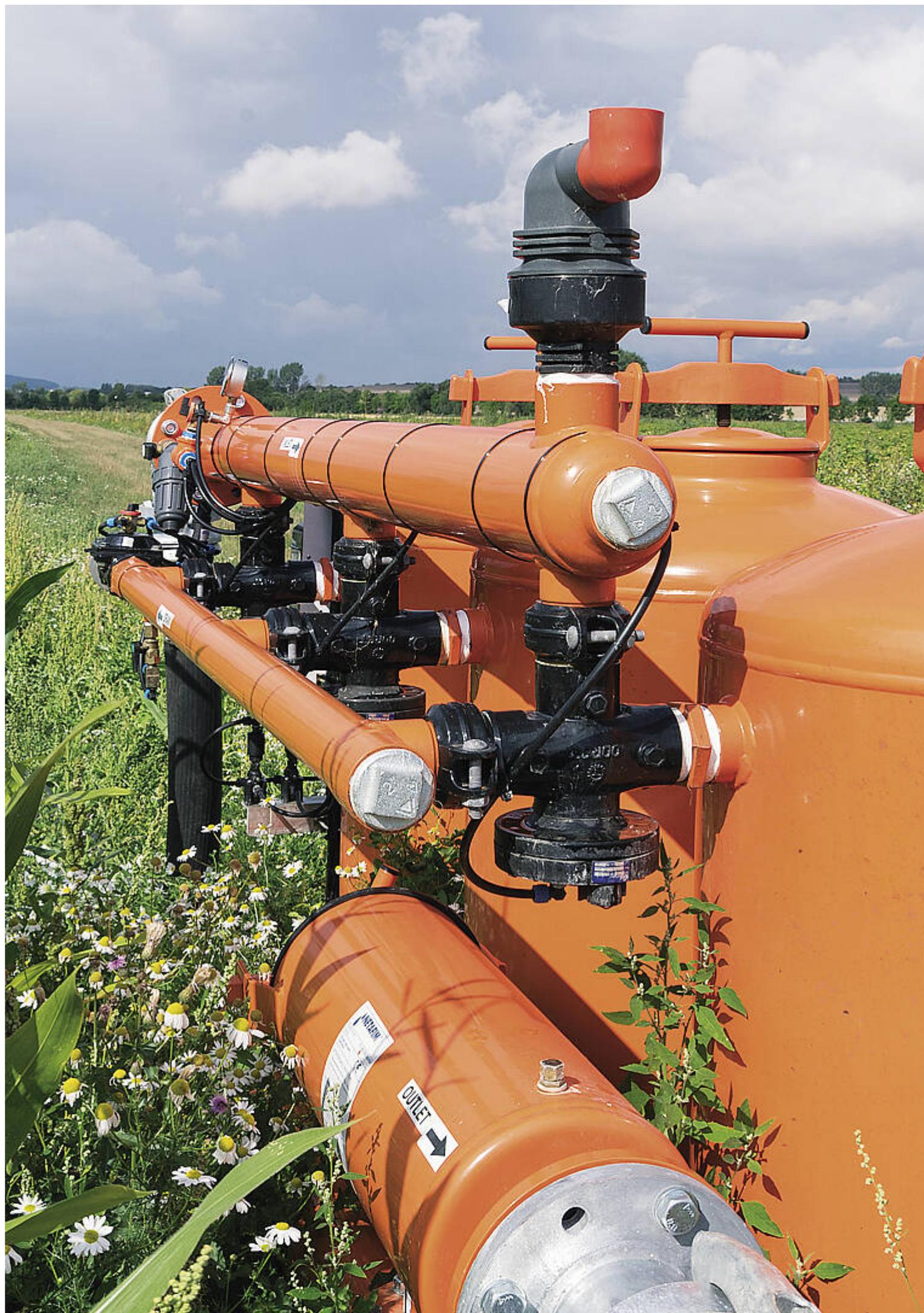
Wegen der Algenbelastung des Wassers aus der Talsperre wurde bei dem Tropf-bewässerungssystem in Andisleben vor die Kopfstation ein Kiesfilter installiert.
