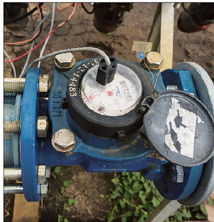
Von der Kopfstation führen die Verteilungsleitungen zum Tropfbewässerungssystem im Kartoffelfeld. Wasseruhr in der Kopfstation elektronischer Erfassung des Zählerstandes für die Überwachung und Steuerung.
