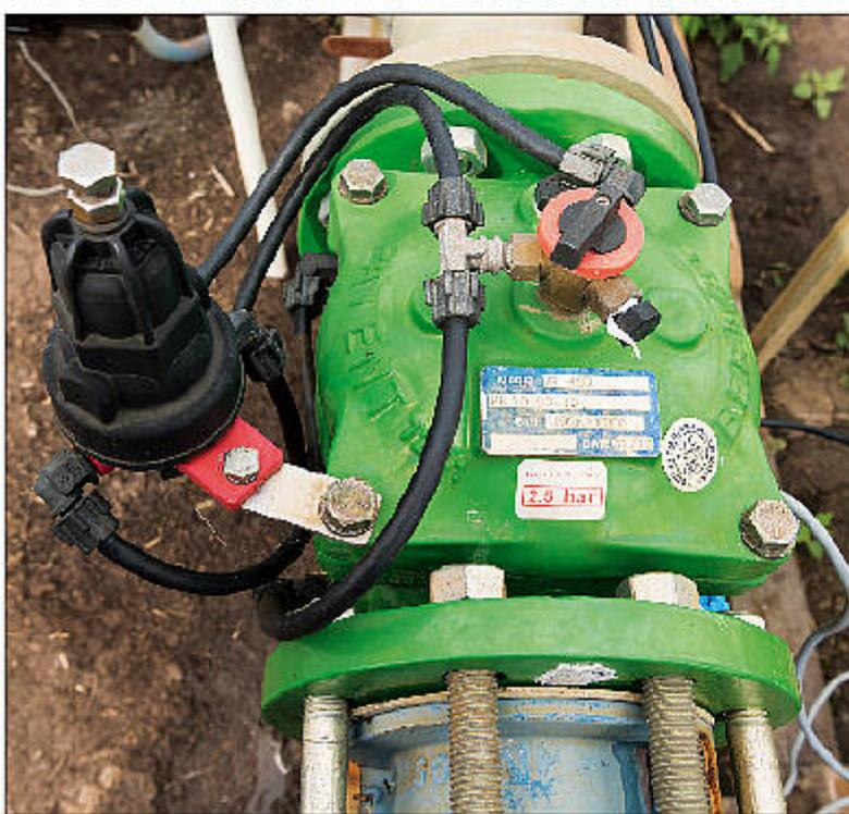
Kopfstation des Tropfbewässerungssystems mit Düngerdosierer, Filter, Druckminderer und Automatisierungseinheiten. Druckmi
